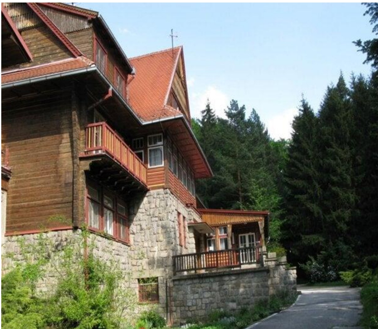
Čatlošova vila je roky nevyužívaná. (zdroj: Železná studnička, a.s. )
